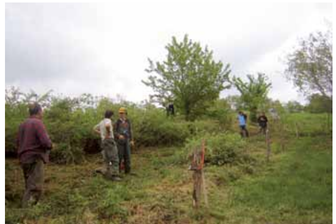
Débroussaillage et arrachage d'arbustes
